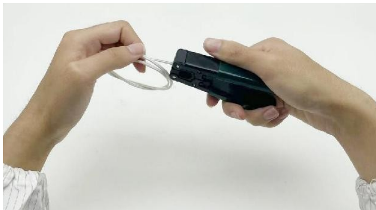
Abbildung 3.6 Vorbereitung des Abzweigkabels
